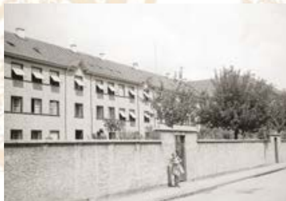
Ansicht Fassade der Häuser strassenseitig Richtung Osten
