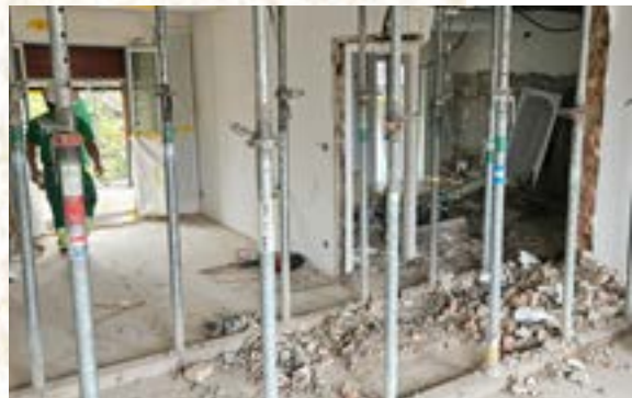
Spriessung der Deckenkonstruktion
