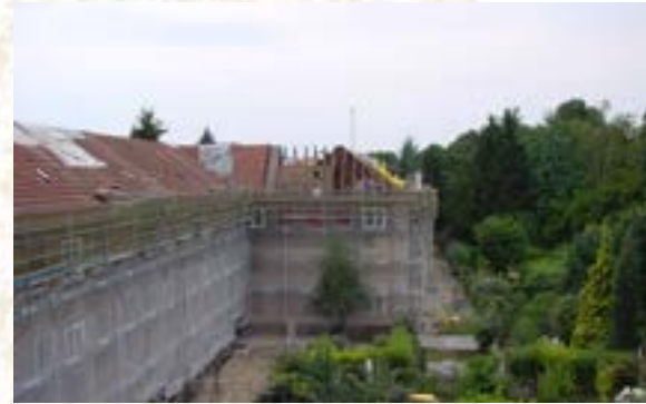
Abbruch Dach, Haus Im Heimat- land 21
