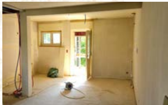
Entkernung der zukünftigen Alterswohnungen
