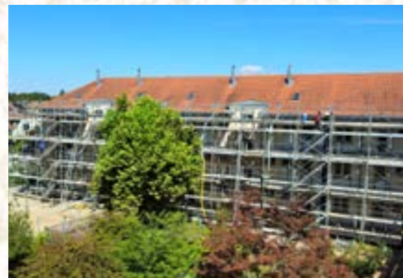
Häuser 76, 78 und 80 voll ein- gerüstet
