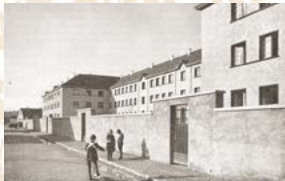
Ansicht Fassade der Häuser strassenseitig Richtung Westen
