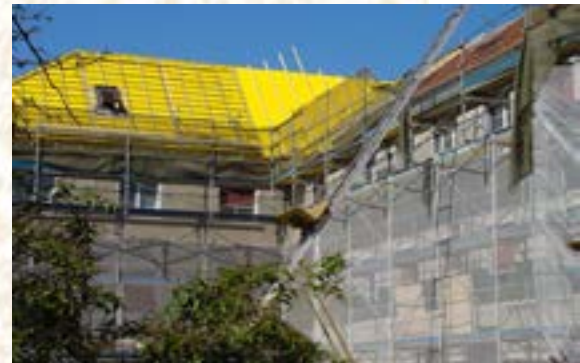
Neues Dach, Haus Im Heimat- land 11
