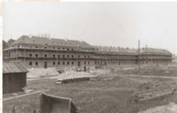
Ansicht Baustelle strassenseitig Richtung Osten, 1926
