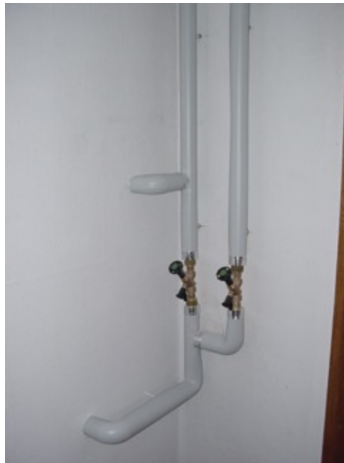
Leitungsführung Treppenhaus Haus 19
