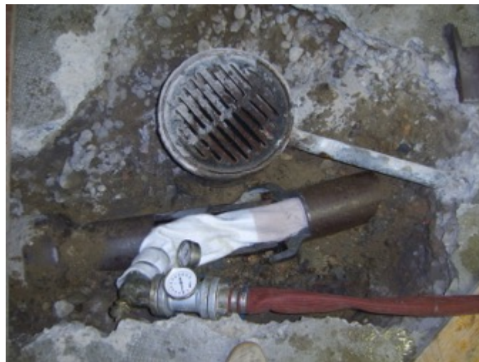
Inliner Vorgang Haus 19
