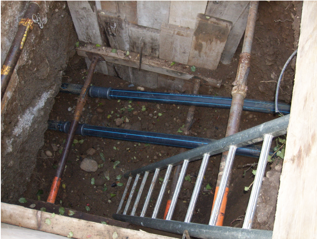
Neue Wasserleitungen zum Haus 9 und 11
