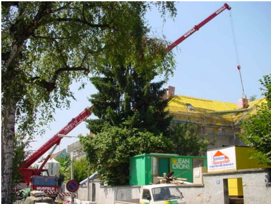
Abbildung 15 – Anlieferung der Dachziegel
