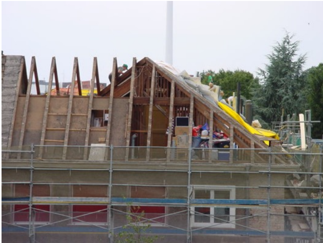
Abbildung 12 – Dacharbeiten im Haus 80
