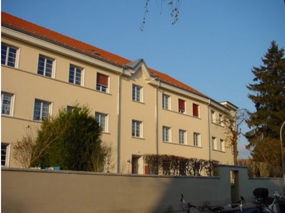
Abbildung 10 – Haus 25 nach der Fassadenrenovation
