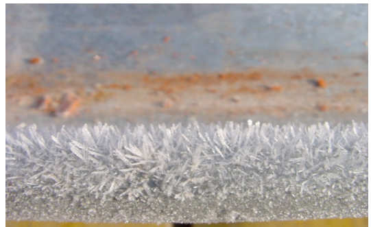
Abbildung 13 – Eisbildung im Dachkännel
